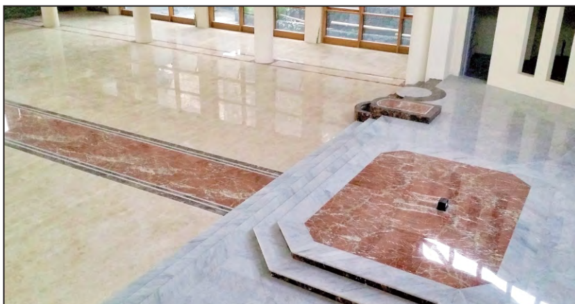
Realizzazione e rifinitura di alcune componenti dell'area presbiterale
