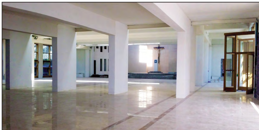
Posa in opera del pavimento in marmo
