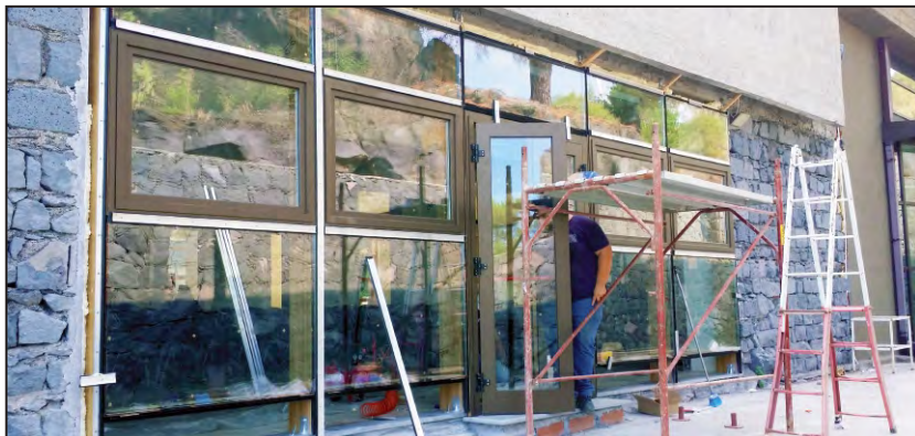
Allargamento di vano apertura della parete est con inserimento di un modulo di parete continua a vetro.
