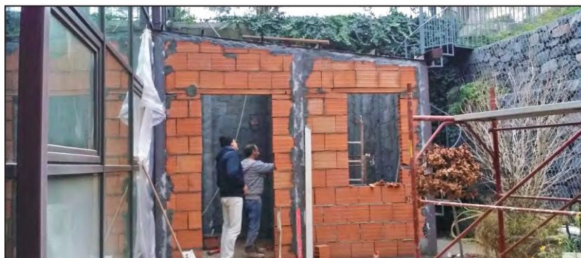
Realizzazione di un locale adibito a servizio igienico disabili con antibagno
