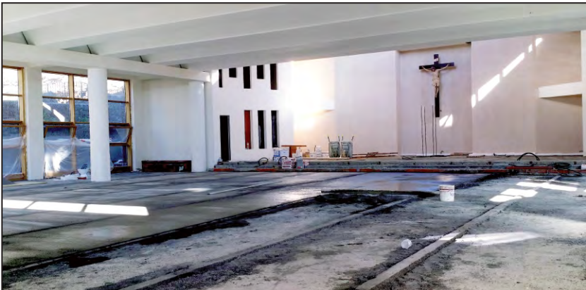
Posa in opera del massetto di sottopavimentazione
